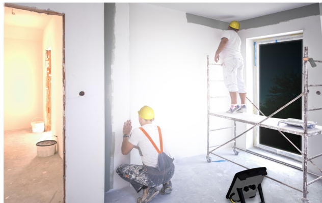
Anwendungsbeispiel: Baustelle Application example: Construction site
